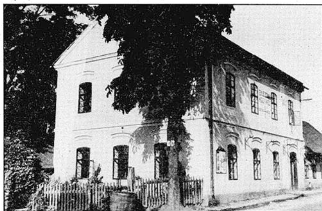
Zájezdni hostinec Prokopa Místeckého – stával naproti dnešní poště.
